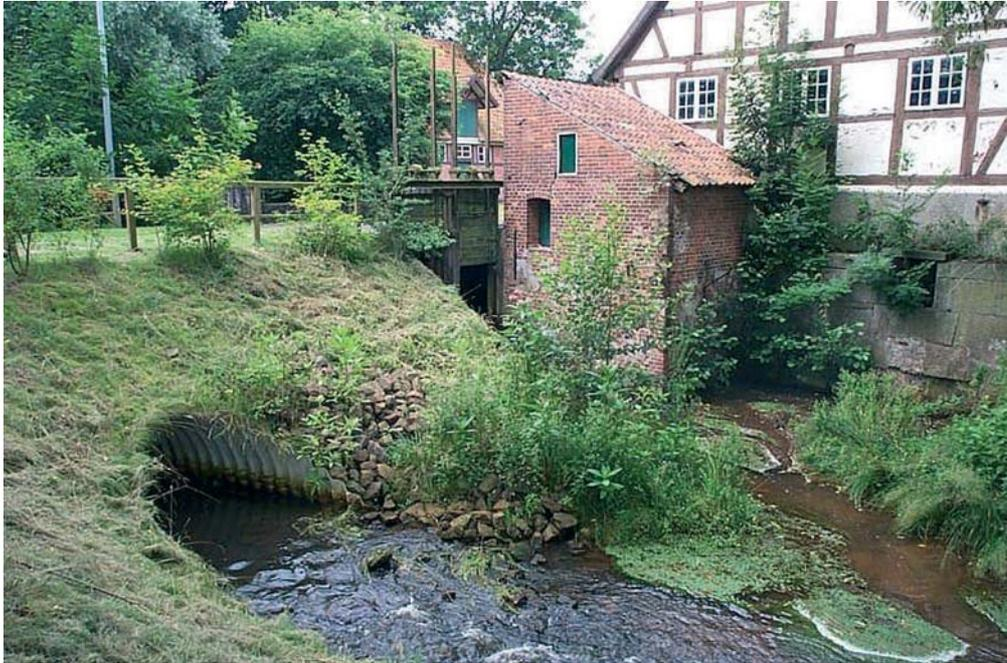
Abb. 19: Mühlenumflut über das Hamco-Wellstrahl-Maulprofil in Neubruchhausen
