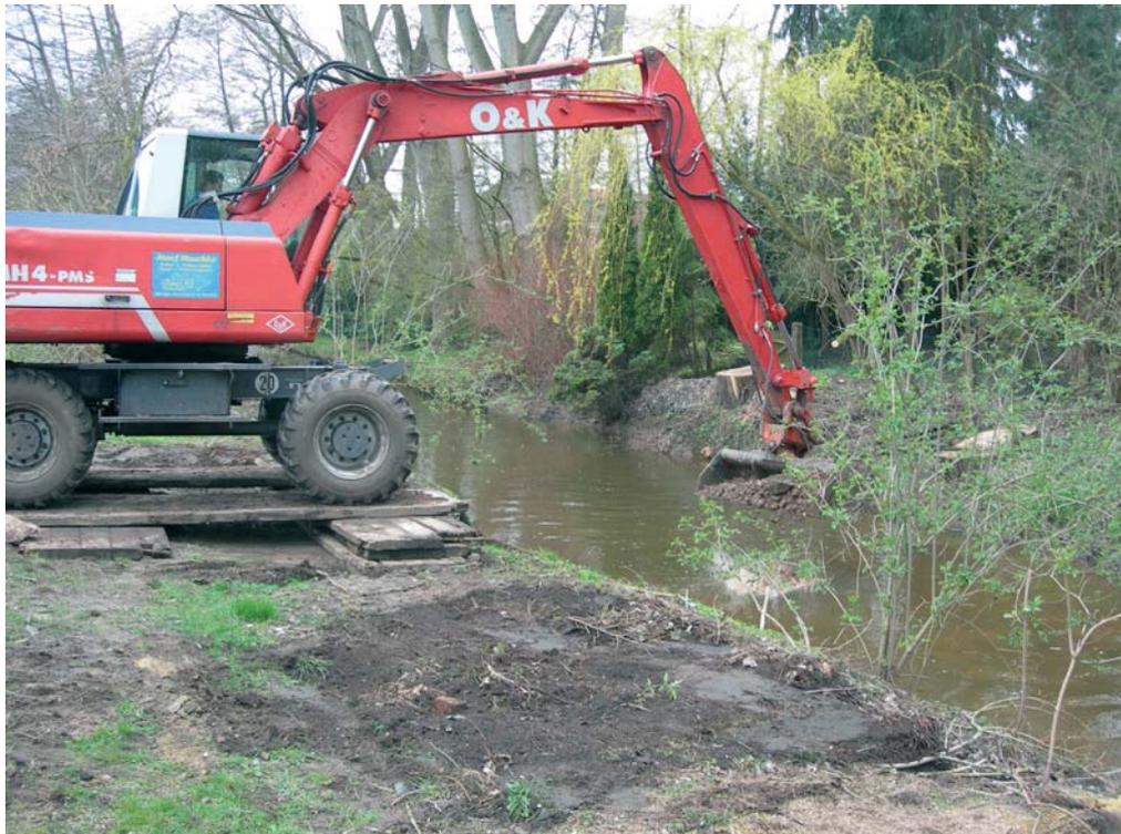
Abb. 29: Einbau der Kiesbank in die Hache hinter dem THW
