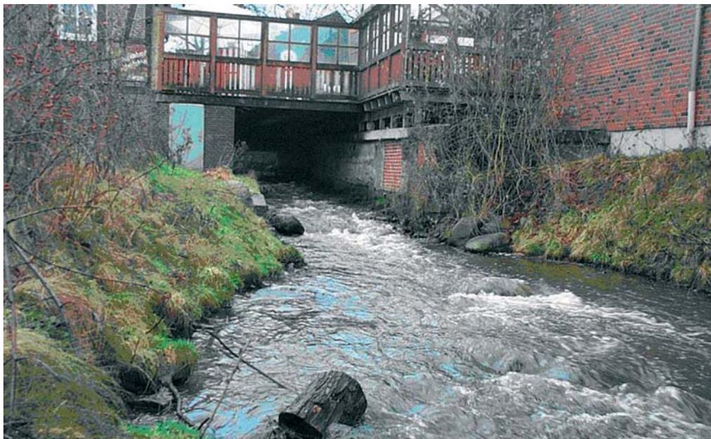
Abb. 18: Ehemalige Mühle Syke – Blick von unterhalb in den Mühlenkanal, auf die Sohlgleite der Hache und die sich darüber befindliche Biergartenterrasse
