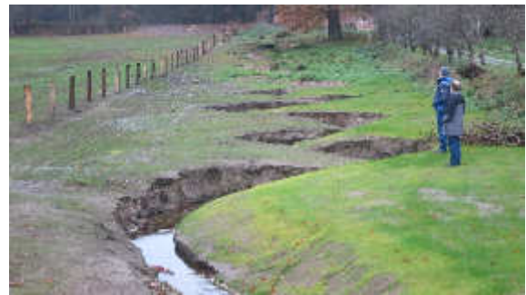
Bild 9 Stat. ca. 0+380 - An die Hofzufahrt Meyer verlegte Twillbeeke kurz nach dem Ausbau - BgF Aufnahmedatum: 30.11.2013
