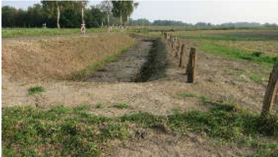
Bild 8 Stat. ca. 0+320 - Neuer Sandfang westlich der K 125 - Blick nach Süden
